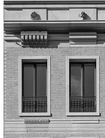
Stadthaus Friedrichswerder Berlin, Fassade mit Spolien des Vorgängerbaus
